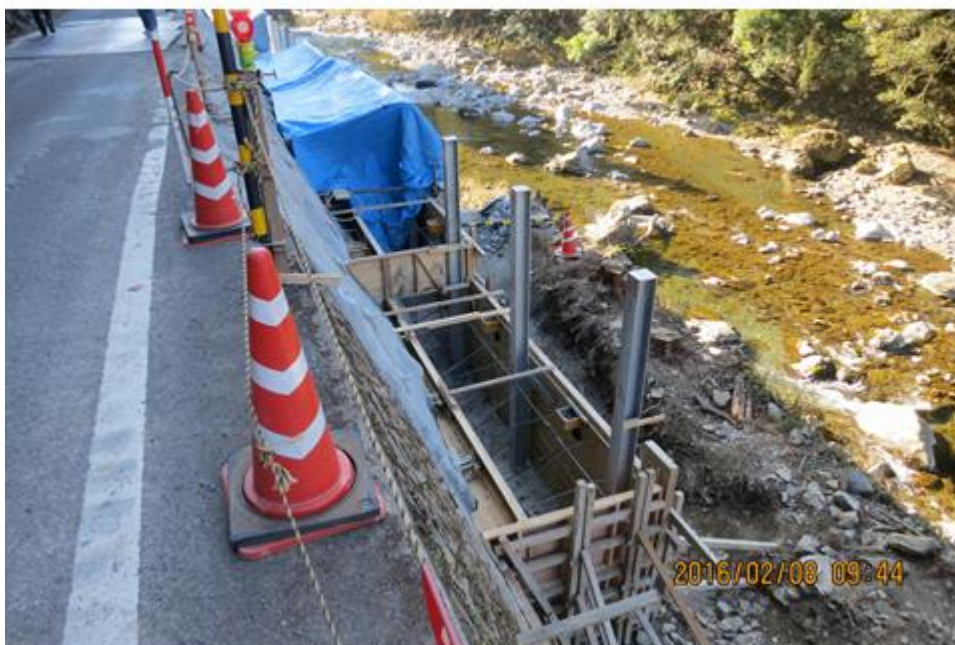
写真一 4 7 定置式クレーンが設置されていない日本の工事現場 (著者撮影；小さい部材からなる型枠)
