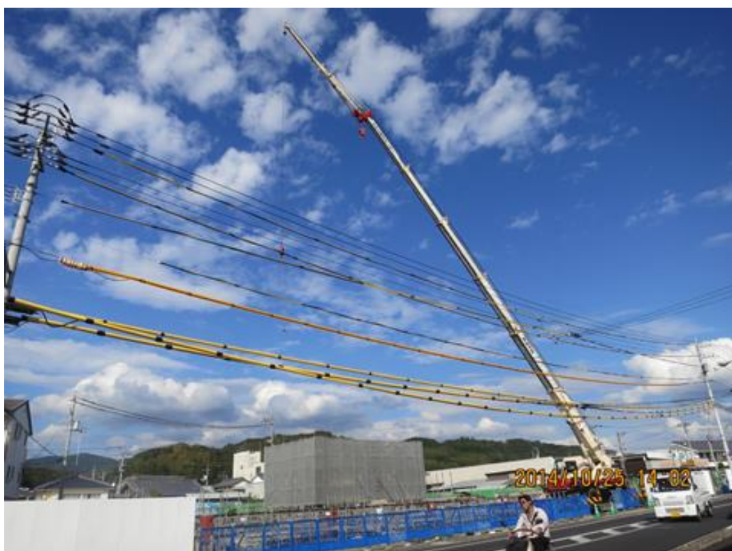
写真－ 7 香美市消防署新築工事現場（移動式クレーンがいる状況） （著者撮影）
