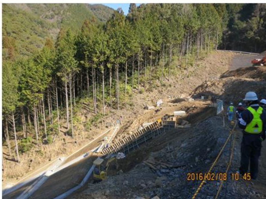
写真一 4 8 定置式クレーンが設置されていない日本の工事現場 (著者撮影；高知県四万十市付近の法面復旧工事)
