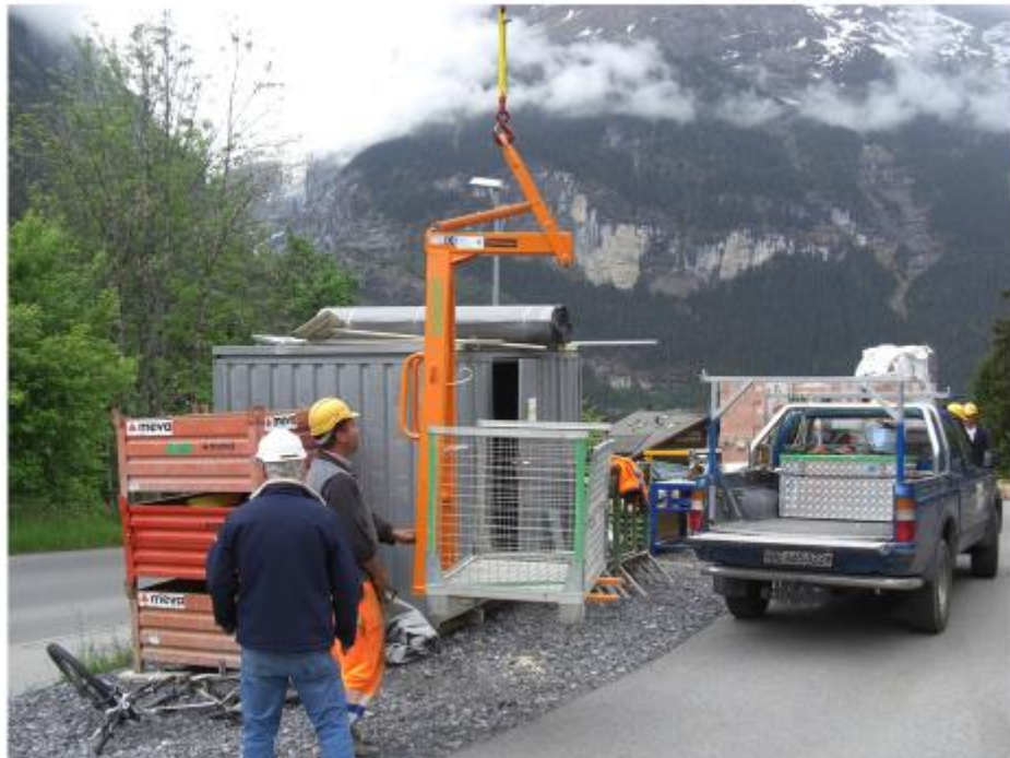
写真—34 定置式クレーンが設置されたスイスの工事現場（著者撮影） （ベルトに固定した無線操作盤でフォーク型吊り治具を操作）
