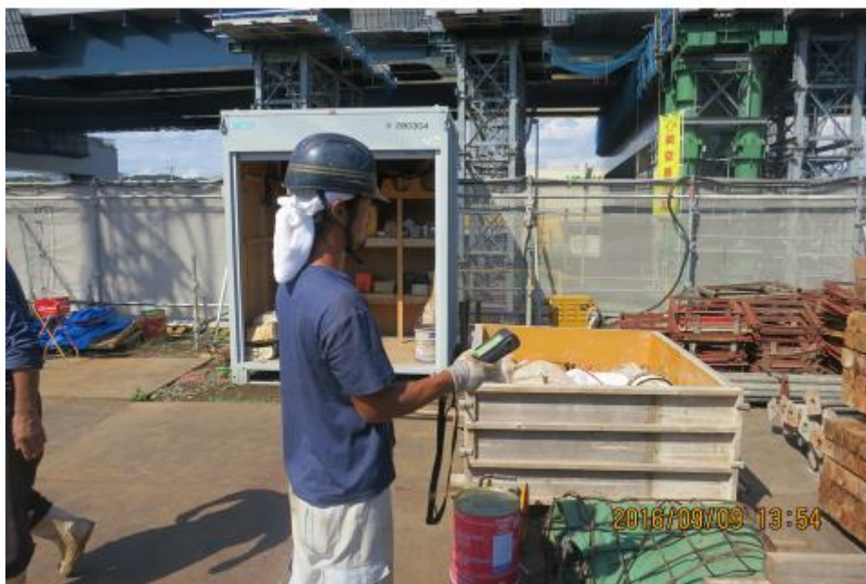
写真一 2 8 定置式クレーンが設置された日本の工事現場（著者撮影） （平型の無線操作盤を手持ちで操作）
