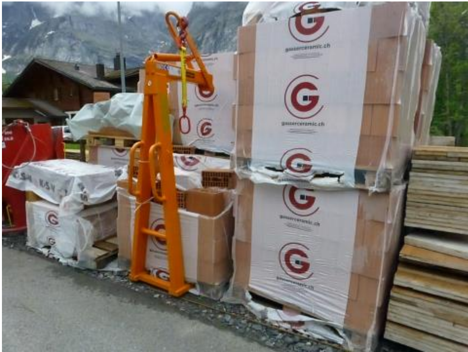
写真一 3 7 定置式クレーンが設置されたスイスの工事現場（著者撮影） （フォーク型吊り治具と木製パレット）
