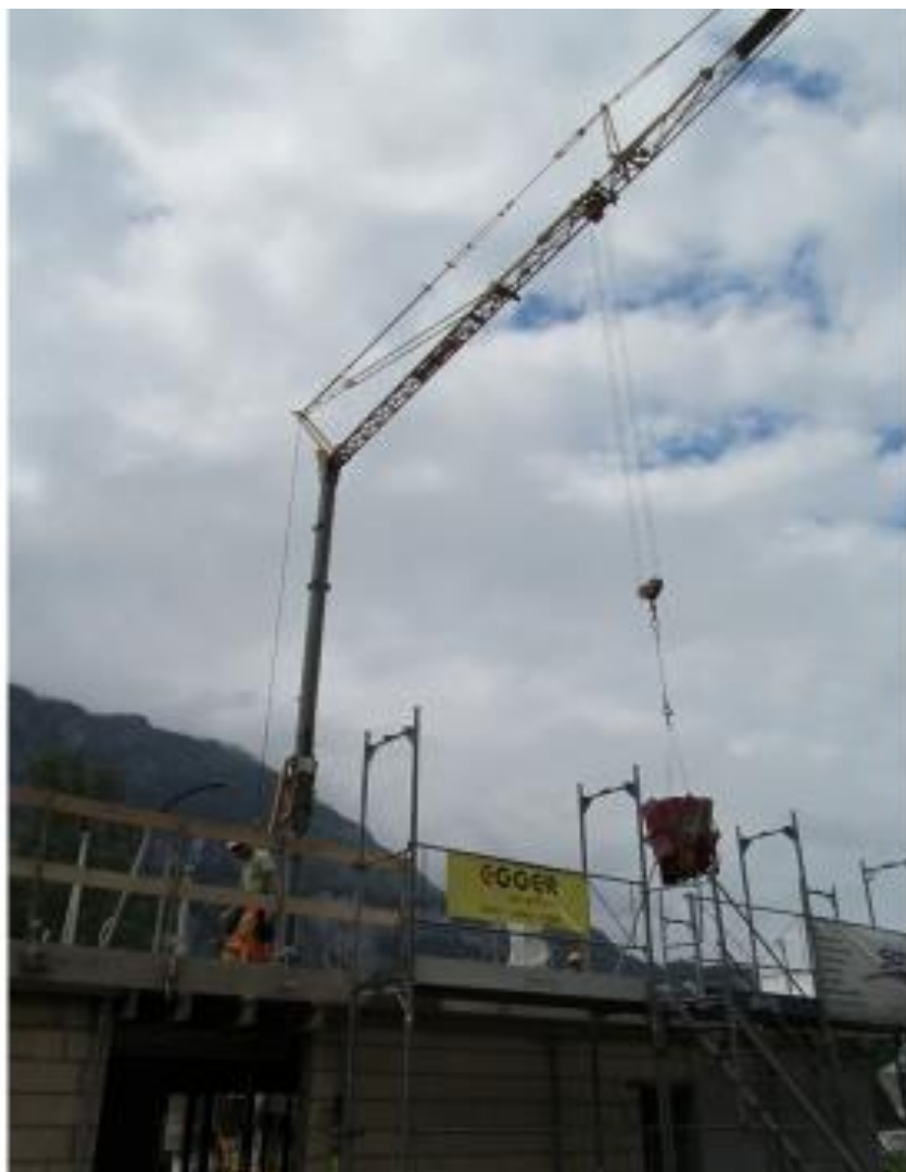
写真—11 定置式クレーンを設置したスイスの小規模な工事現場の一例 (著者撮影)
