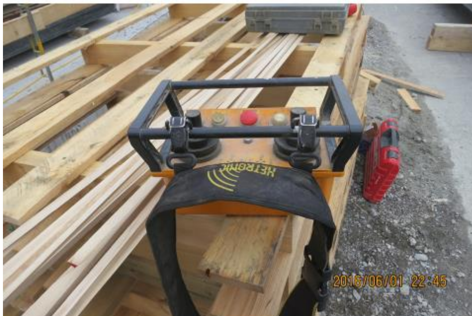
写真一 3 0 定置式クレーンが設置されたスイスの工事現場（著者撮影） （箱型の無線操作盤、ベルトで腰に装着・固定して操作）
