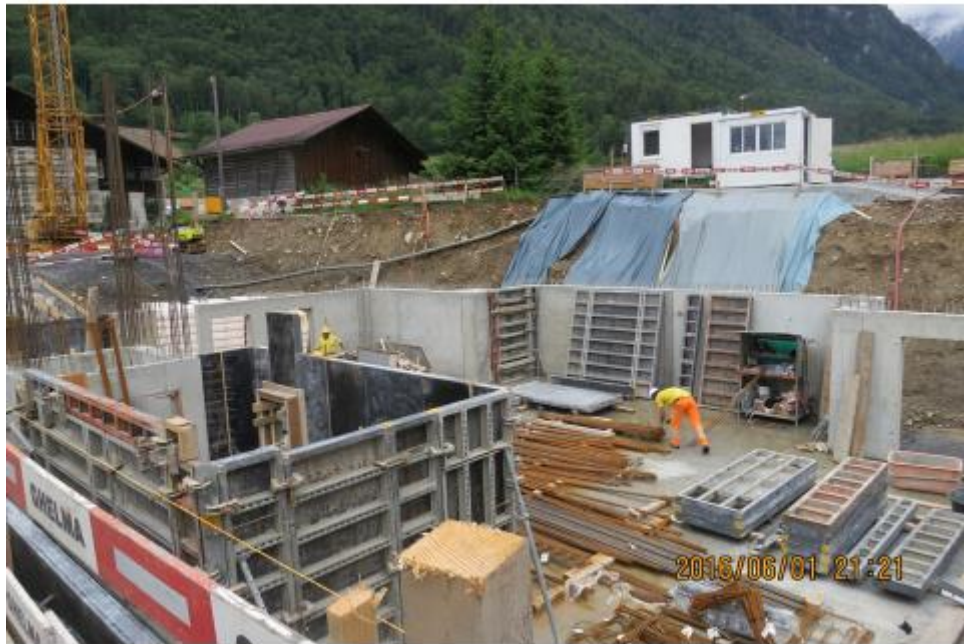
写真ー 2 6 定置式クレーンが設置されたスイスの工事現場（著者撮影） （大ブロックの型枠の組み立て・解体）
