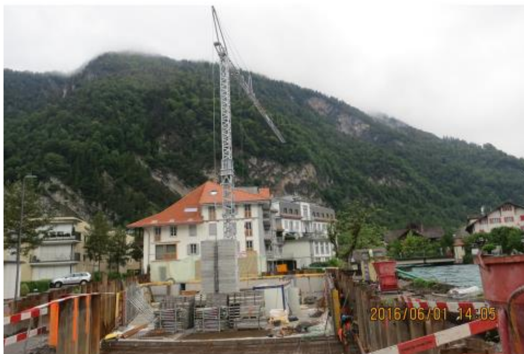
写真一 1 3 定置式クレーンを設置したスイスの小規模な工事現場の一例 (著者撮影)
