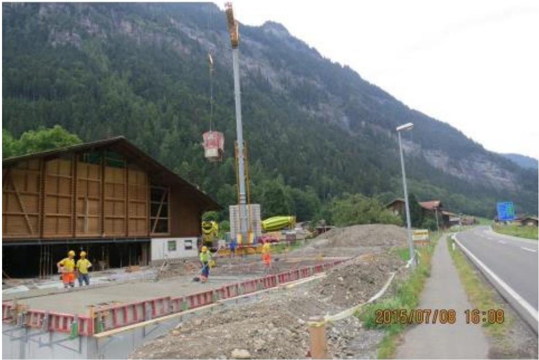
写真一 4 4 カール・アンデレグ社の工事現場
