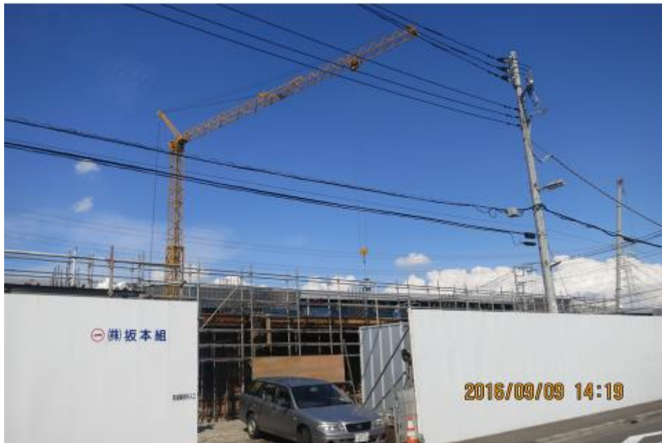
写真一 1 6 日本の定置式クレーンが設置された工事現場（著者撮影）
