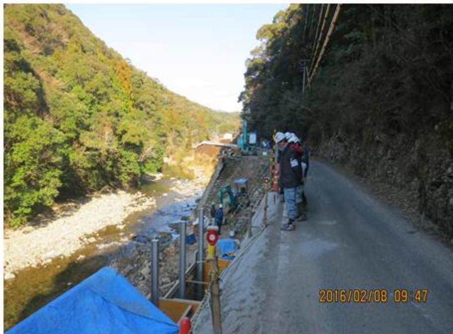
写真一 4 6 定置式クレーンが設置されていない日本の工事現場 (著者撮影；高知県四万十市付近の道路改修工事)
