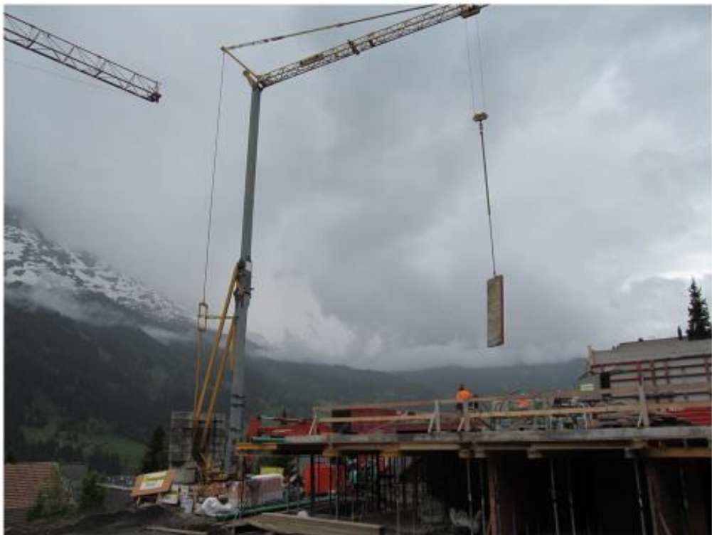
写真一 1 5 定置式クレーンを設置したスイスの小規模な工事現場の一例 (著者撮影)
