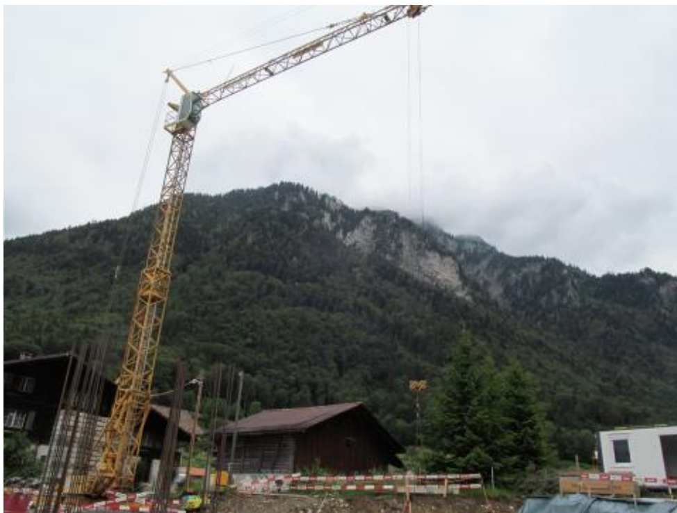
写真一 1 2 定置式クレーンを設置したスイスの小規模な工事現場の一例 (著者撮影)
