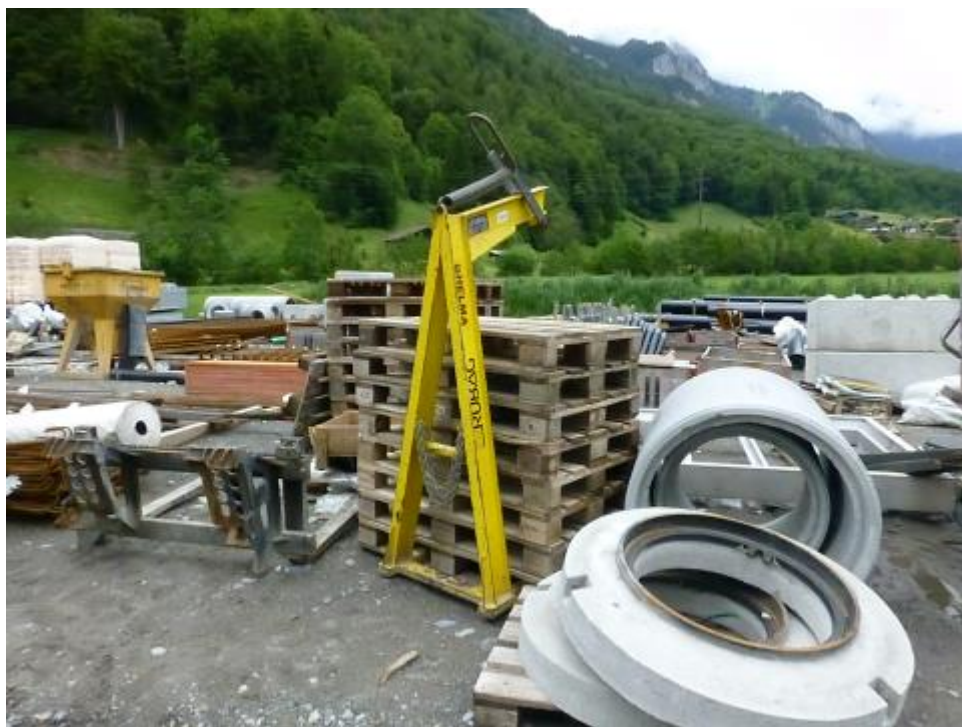
写真一 3 6 定置式クレーンが設置されたスイスの工事現場（著者撮影） （フォーク型吊り治具と木製パレット）
