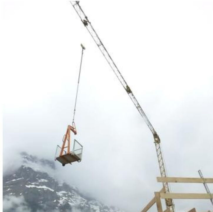
写真一 3 5 定置式クレーンが設置されたスイスの工事現場（著者撮影） （フォーク型吊り治具で運搬用金籠を運搬）
