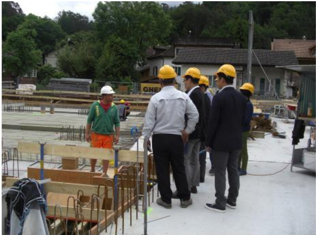
写真一４１ Polier; 職長に、工事日報について聞き取り調査
