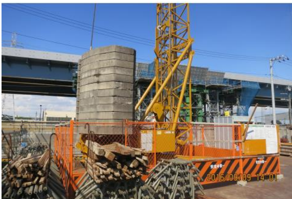
写真一 1 8 日本の定置式クレーンが設置された工事現場（著者撮影） （アンカー無しでウェイトによる固定）
