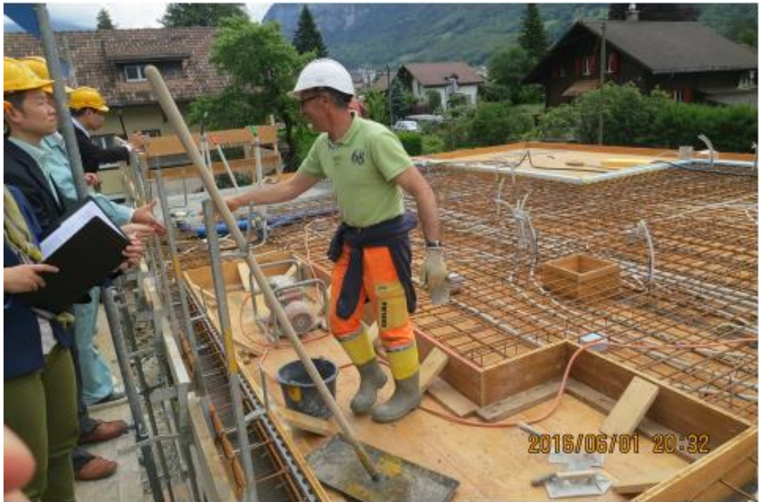
写真一 4 2 Polier; 職長に、工事日報について聞き取り調査
