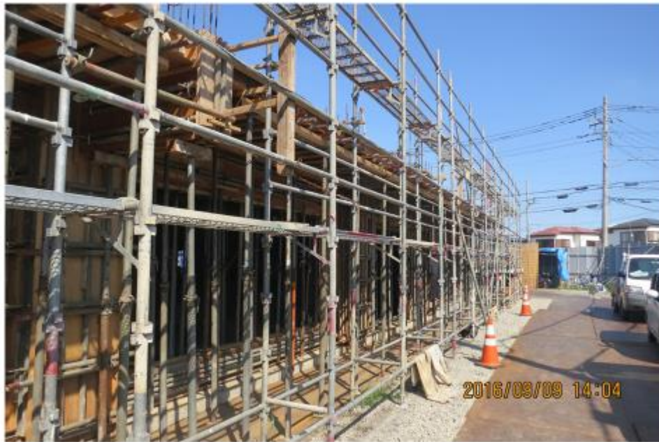
写真一 2 4 定置式クレーンが設置された日本の工事現場（著者撮影） （小さい部材の足場、支保工、型枠）
