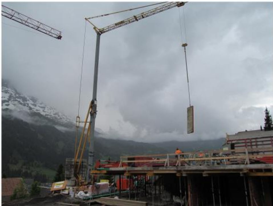
写真一 3 8 定置式クレーンが設置されたスイスの工事現場（著者撮影） （大型型枠を専用吊りチェーン治具で運搬）
