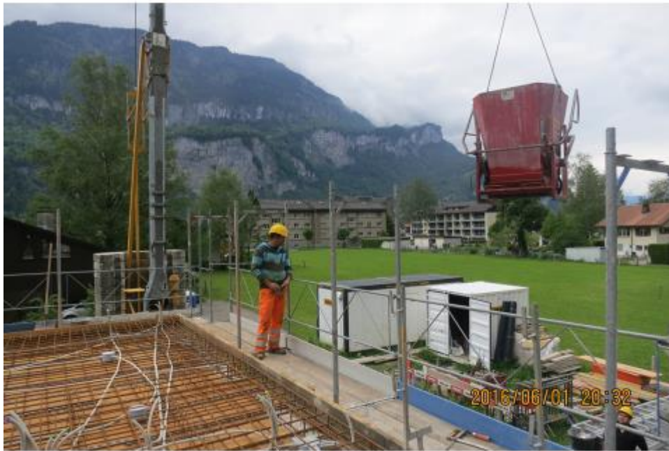
写真—3 1 定置式クレーンが設置されたスイスの工事現場（著者撮影） （ベルトに固定した無線操作盤を操作してコンクリートバケットを運搬）
