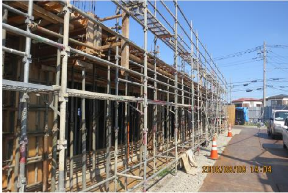
写真一 2 2 日本 の 定 置 式 クレーン が 設 置 さ れ た 工 事 現 場 ( 著 者 撮 影 ) ( 小 さ い 部 材 の 足 場 、 支 保 工 、 型 枠 )
