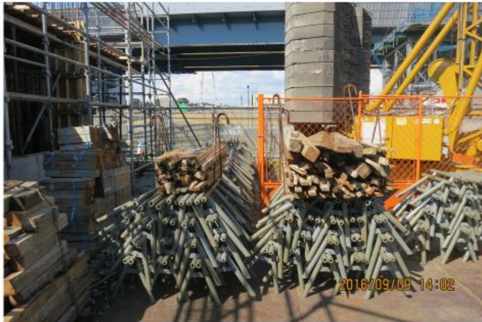
写真一 2 3 日本 の 定 置 式 クレーン が 設 置 さ れ た 工 事 現 場 ( 著 者 撮 影 ) ( 玉 掛 け ワイヤ ー に よ る 吊 り 上 げ を 想 定 し た 荷 姿 )
