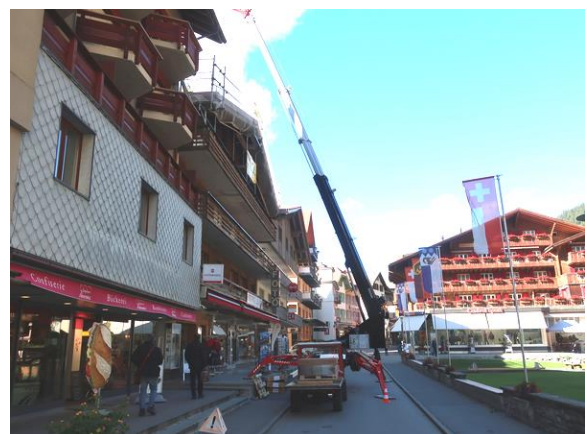
クローラー付きカニクレーンによる荷揚げ
