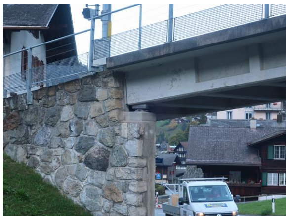
鉄道橋の支承部
