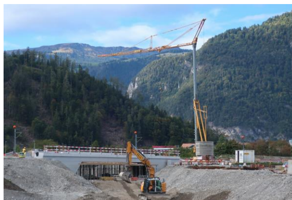
道路改築工事に伴う鉄道橋の施工現場
