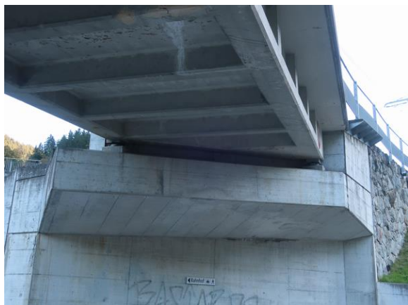
鉄道橋の桁下面
