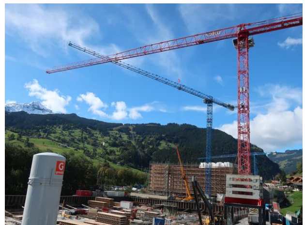
V-Bahn Grund 駅の工事現場(大型水平ジブクレーン)
