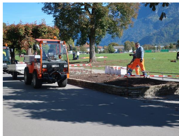
インターラーケン市の公園での造園工事
