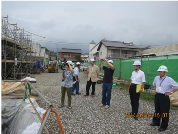
写真 5 香美市消防署新築工事現場視察 (中央がゲルマ社長) (著者撮影)
