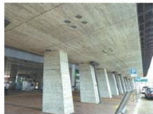
高知で見た打ち放しコンクリート
