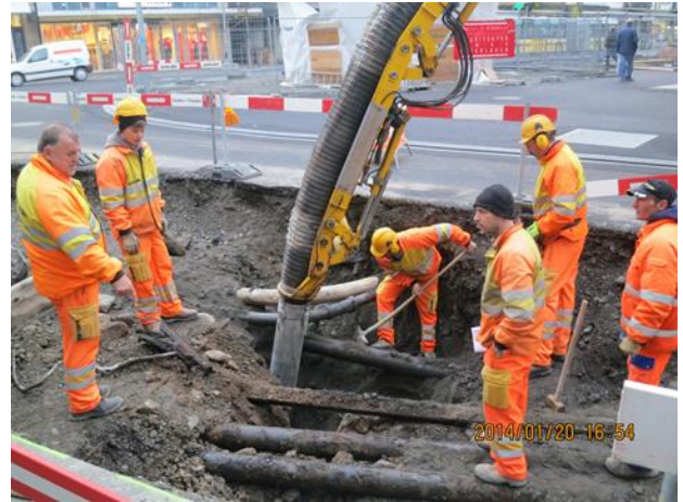
写真 10 インターラーケン市内の道路補修工事現場 (朝 8 時前) (著者撮影)
