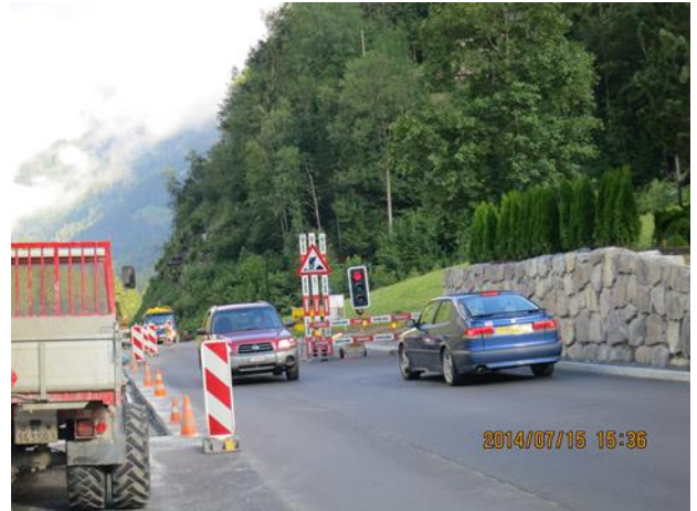
写真 3 インターラーケン市郊外の道路工事現場 (片側交互通行規制) (著者撮影)
