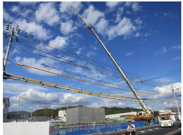
写真 8 香美市消防署新築工事現場 (クレーンがある状況) (著者撮影)
