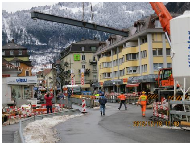
写真 2 インターラーケン市内の道路更新工事 (橋梁掛替え) (著者撮影)
