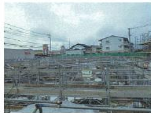
現場の窪みに組まれた足場
