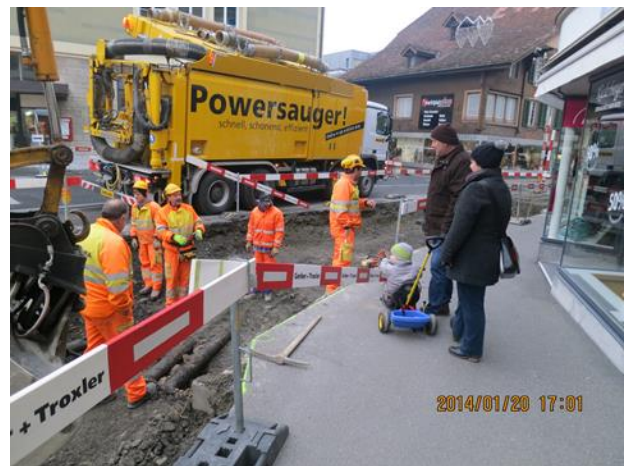
写真 11 インターラーケン市内の道路補修工事現場 (朝 8 時頃) (著者撮影)
