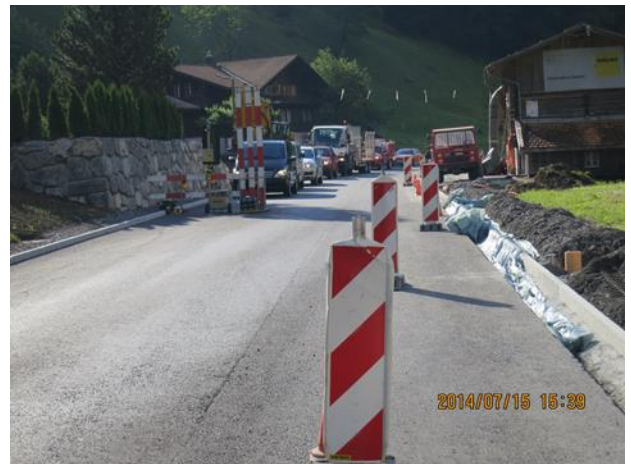
写真 4 インターラーケン市郊外の道路工事現場 (片側交互通行規制) (著者撮影)
