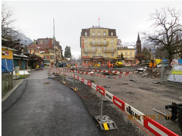
写真 1 インターラーケン市内の道路工事現場 (著者撮影)
