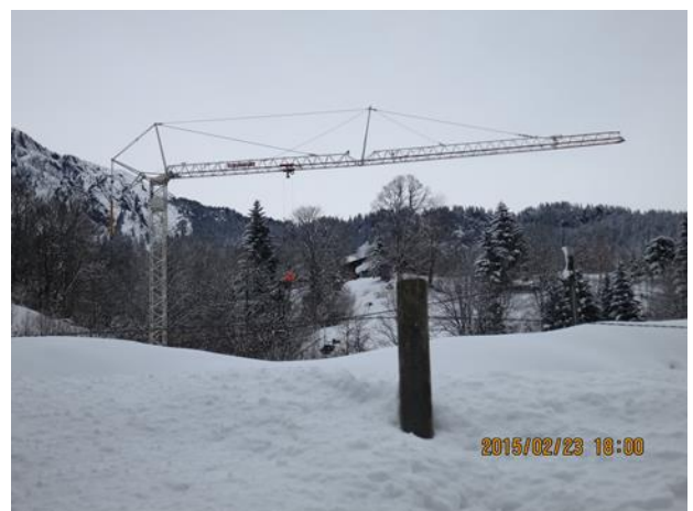
写真 14 建設工事現場の定置式クレーン (インターラーケン市郊外) (著者撮影)
