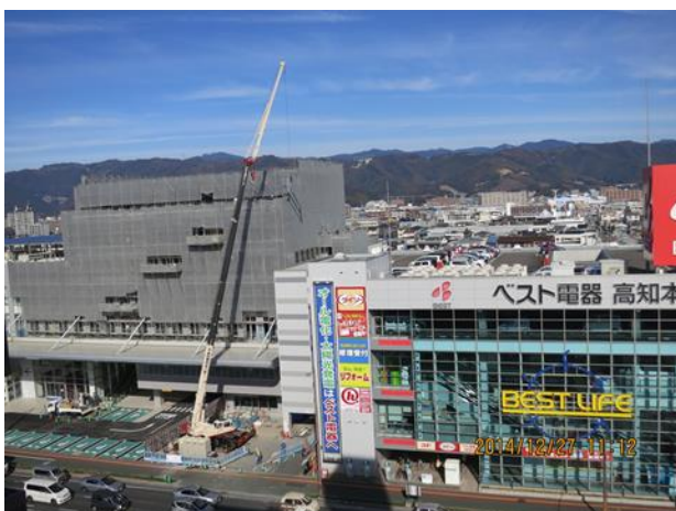
写真 12 建設工事現場の標準的なクレーン使用方法 (高知市内) (著者撮影)
