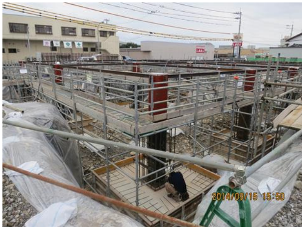
写真 6 香美市消防署新築工事現場 (RC 地中梁を施工中) (著者撮影)
