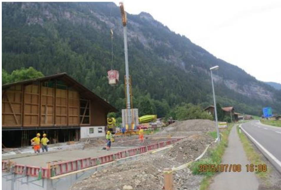
写真一九 カール・アンデレッグ社の工事現場
