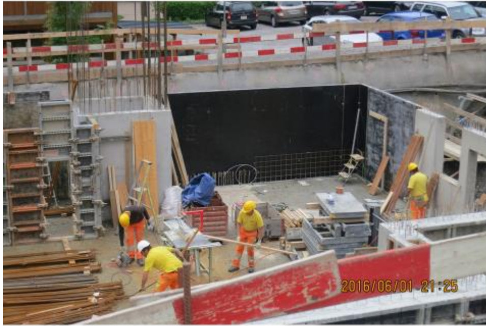
写真一八 ゲルマ社の工事現場；白い安全帽の人物が、Polier；職長
