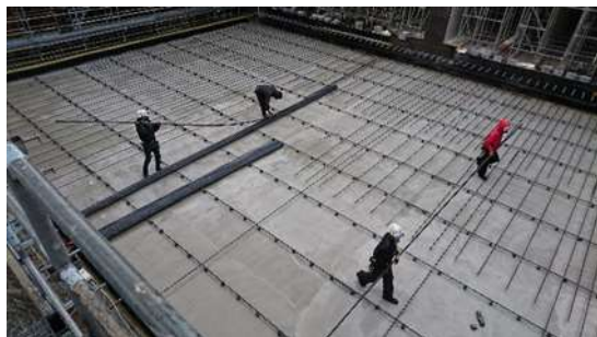
技能労働者による鉄筋の運搬
