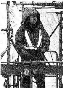
無線操作機を使い目視で確認しながら吊り上げを行う作業員
