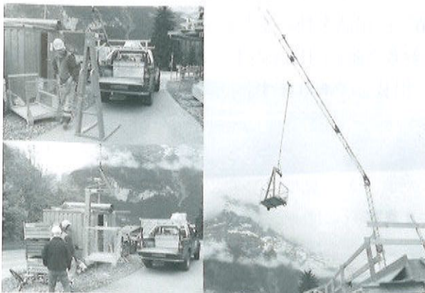
写真5 パレットハンガーと金網籠付パレット（著者撮影）
