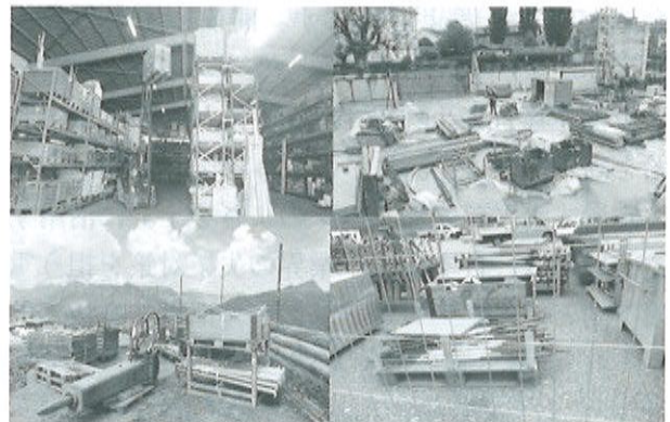
写真7 パレットを活用した資機材の保管・仮置き状況
