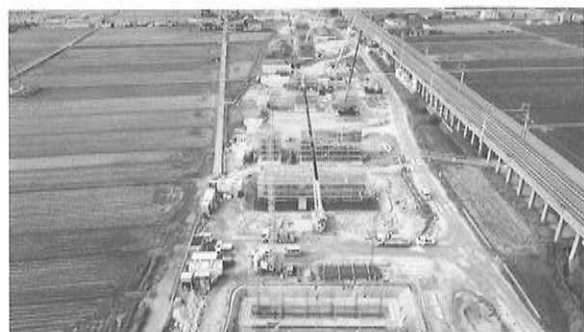
写真4 滋賀県・出庭高架橋の定置式水平ジブクレーン (2021年9月 藤村昭嘉 撮影)
