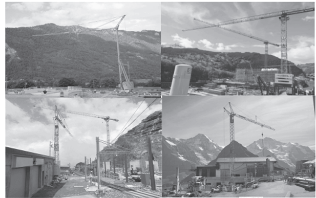
写真3 スイスの工事現場の定置式水平ジブクレーン（著者撮影）
