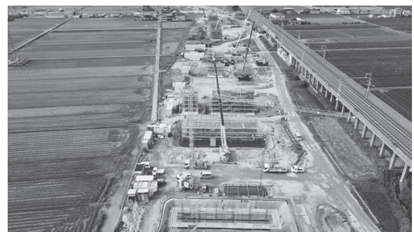
写真4 滋賀県・出庭高架橋の定置式水平ジブクレーン (2021年9月 藤村昭嘉 撮影)
