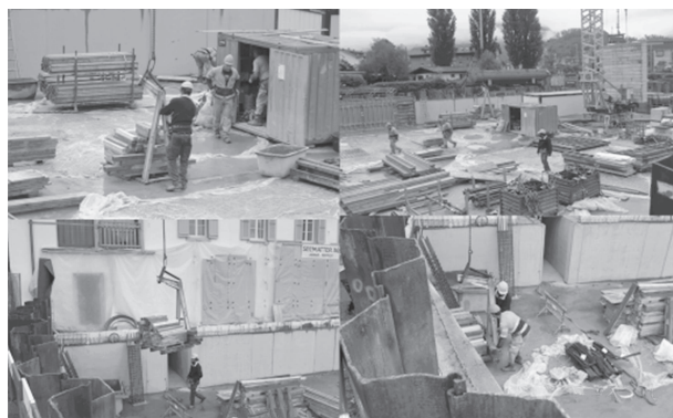
写真6 朝7時始業時の工事現場の作業状況（著者撮影）
